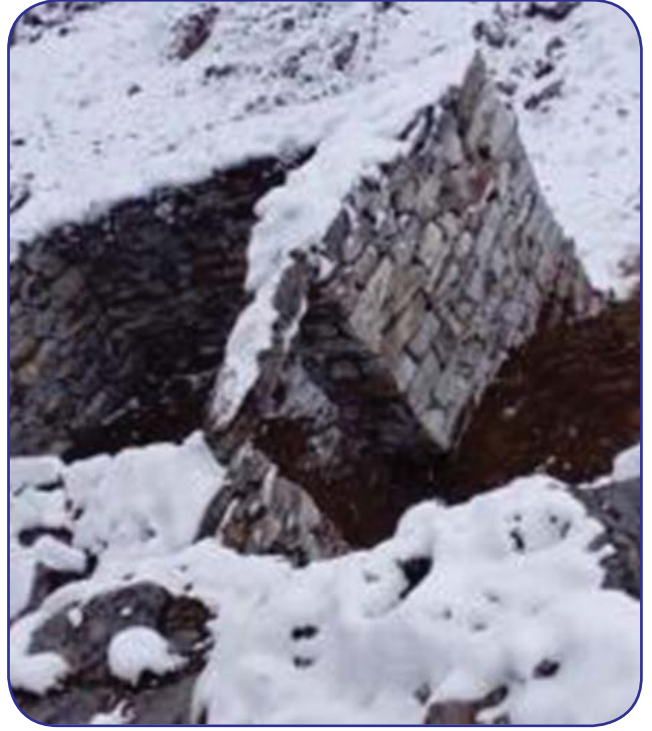
चित्र ६: Campsite construction
