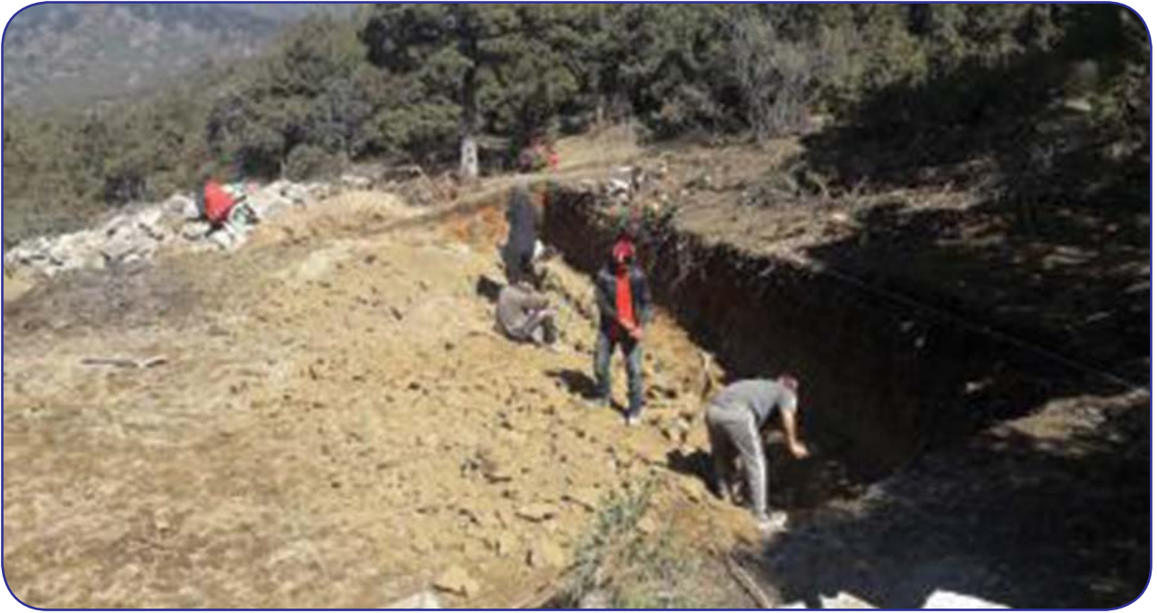
चित्र ५: Syangboche post under construction
