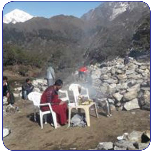
चित्र ६: syangboche post under construction
