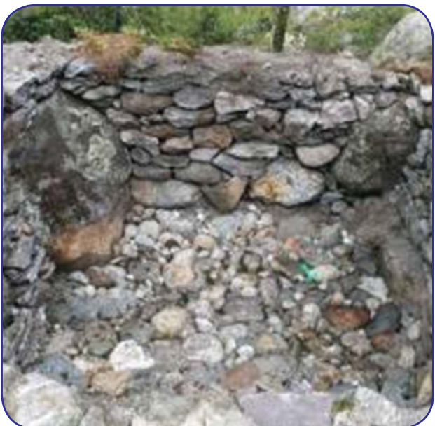
चित्र १२: Rubbish pit construction
