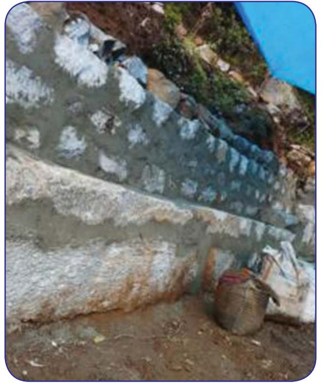
चित्र ४: Resting place construction
