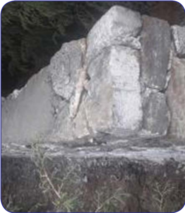
चित्र ९: Compound wall Construction
